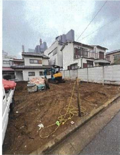
着工前現地写真
